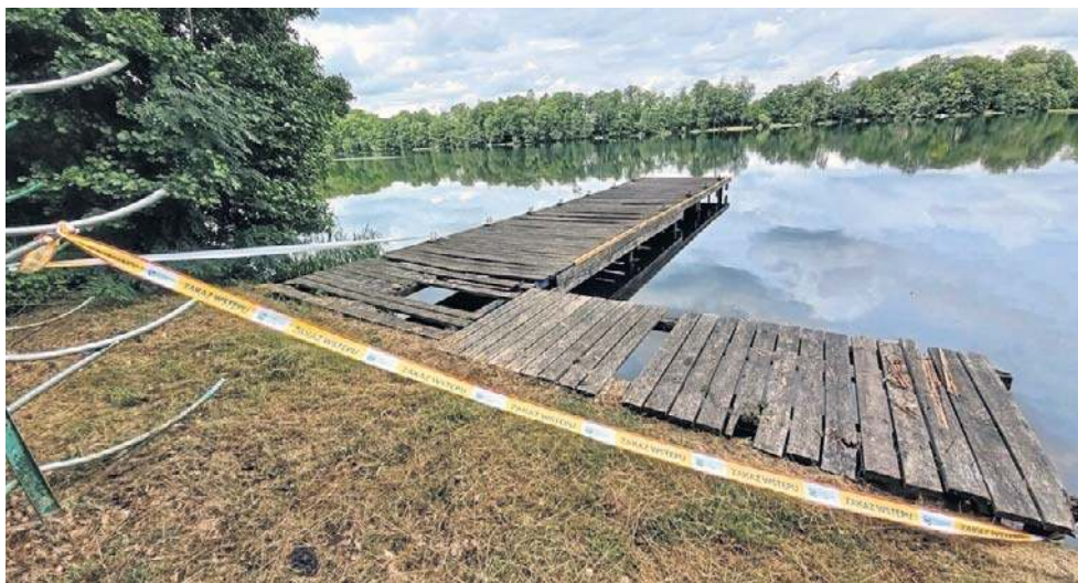
Część pomostów funkcjonuje jako samowole budowlane
