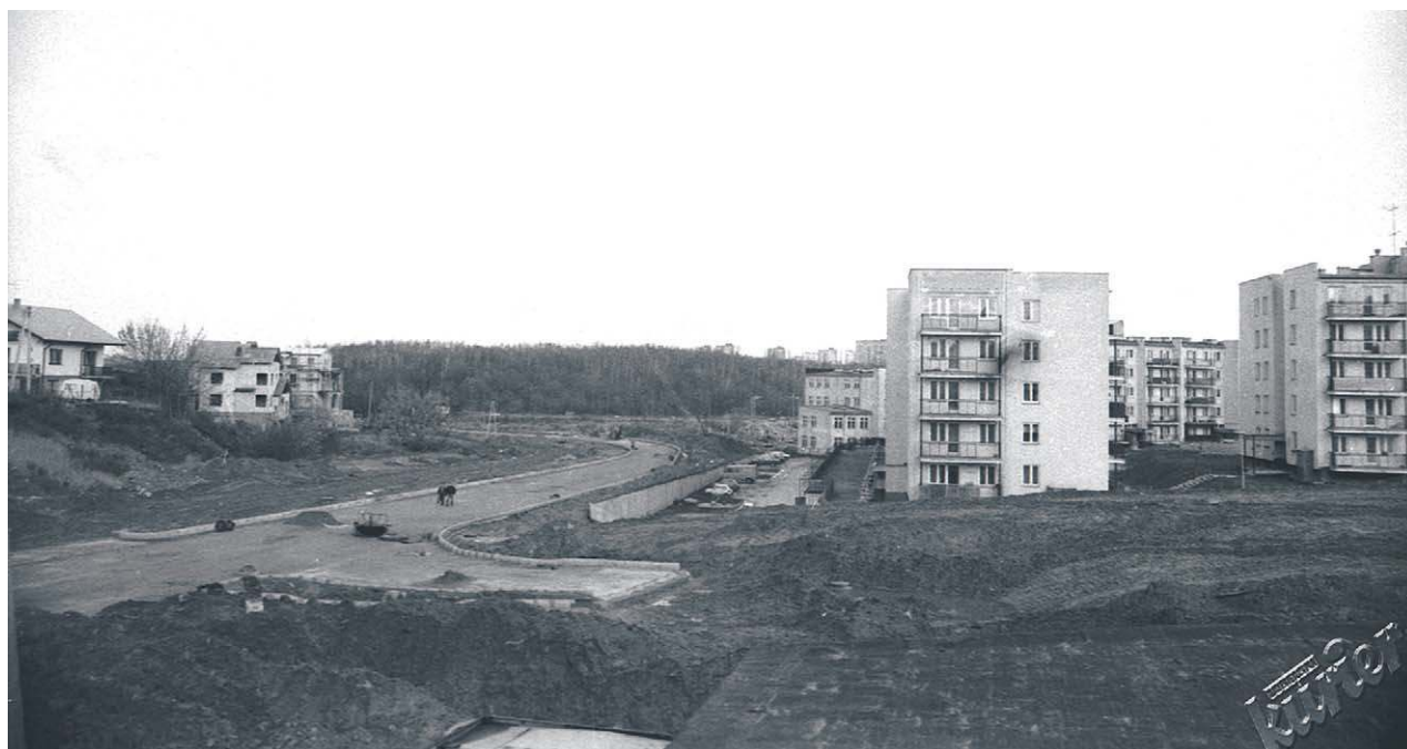
Budowa ul. Sikorskiego, przy skrzyżowaniu z ul. ks. J. Popiełuszki (dawną Różą Luksemburg)
