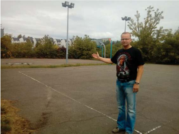
W ramach inwestycji zniszczone asfaltowe boisko pokryte zostanie nową, bezpieczną nawierzchnią i jak zapewnia Sławomir Podlecki, kierownik Placówki Wsparcia Dziennego „Jutrzenka” w Lublinie, po remoncie będzie służyło wszystkim mieszkańcom dzielnicy
