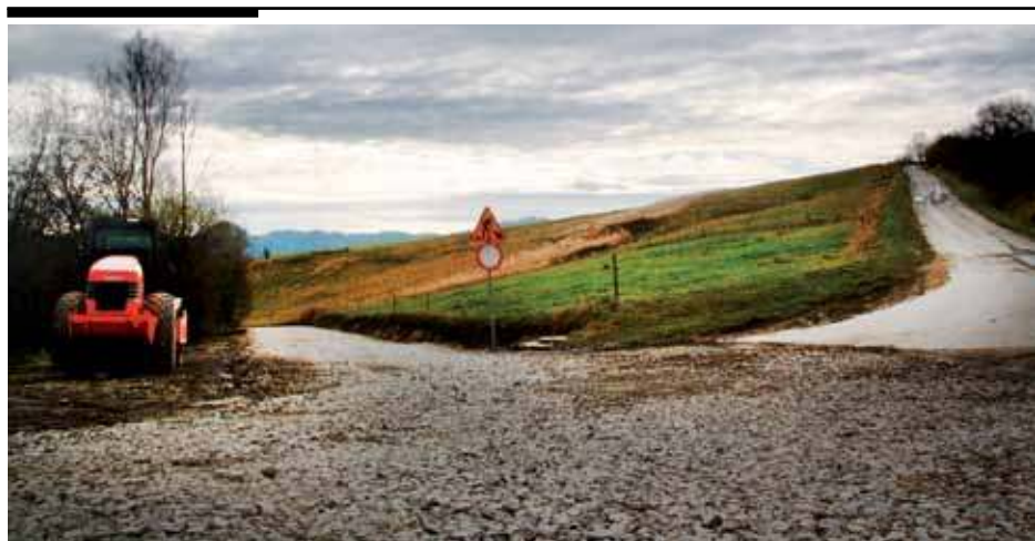
Na ulicy Jana Pawła II w Grywałdzie zmiany. Rozpoczęta przebudowa drogi ma się zakończyć w październiku. Koszt inwestycji oszacowany został na 122 tys. zł.
