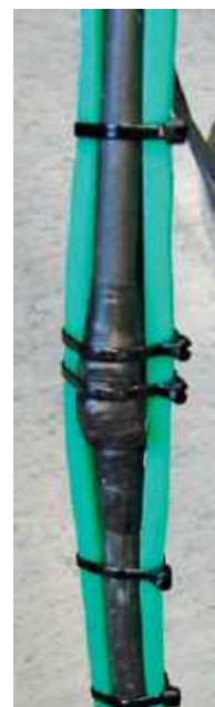
Fot. 3. Jako wzmocnienie połączeń służą plastikowe łubki, do których wiązadłami są przywiązane końce kabli
