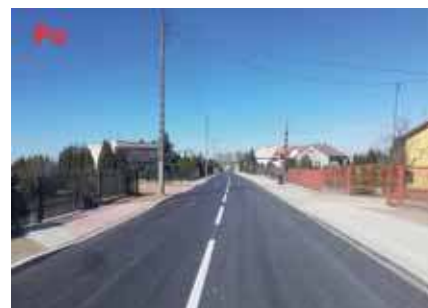
Białowiejska po przebudowie
