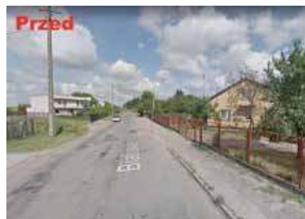
Białowiejska przed remontem
