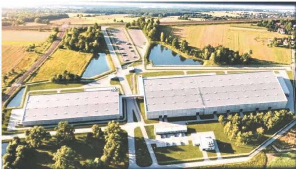
Nowa fabryka „Jelcz” stanie w Miłoszyczach na styku Jelcza-Laskowice i Miłoszycz, przy ul. Długiej, Głównej i Inżynierskiej, nieopodal miejsca, gdzie był stary wieżowiec JZS
