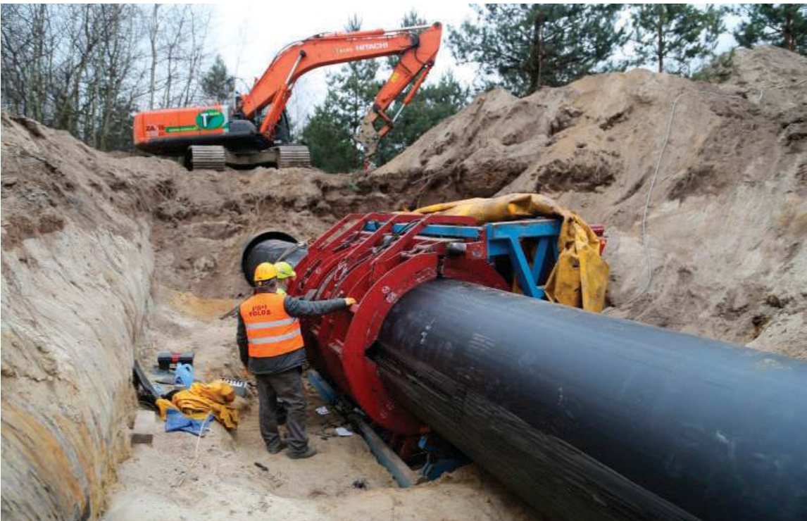
Świdnicka magistrala wodna zostanie zmodernizowana metodą reliningu, czyli wciągania nowej rury w już istniejący wodociąg (zdjęcie ilustracyjne)
