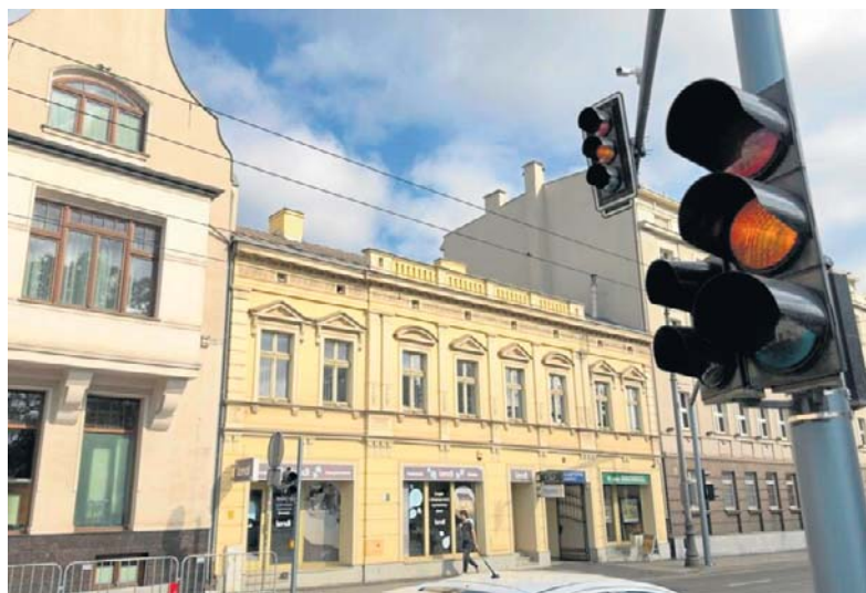
Sygnalizacja przy Focha na wysokości Karmelickiej już stoi. Pasy mają pojawić się wkrótce. Czy jednak parking opery oddany będzie w terminie?
