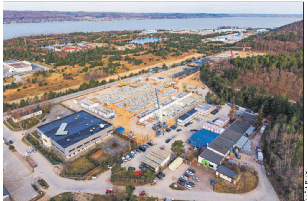
Magazyn Energii Żarnowiec
