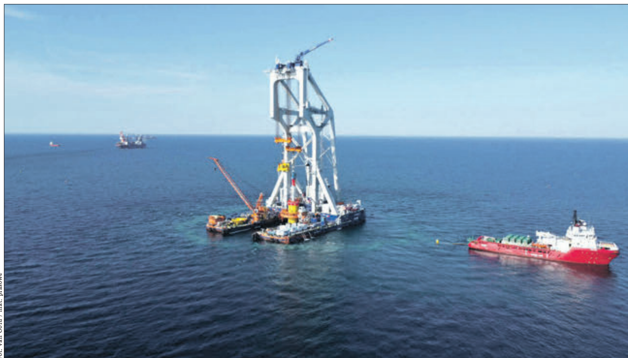
Baltica 2: instalacja fundamentów
