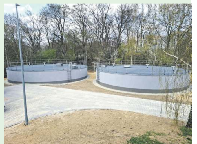
Ukończona budowa dwóch zbiorników wody w Machnicach
