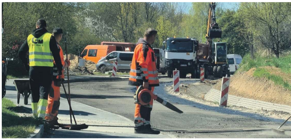
Trwają intensywne prace
