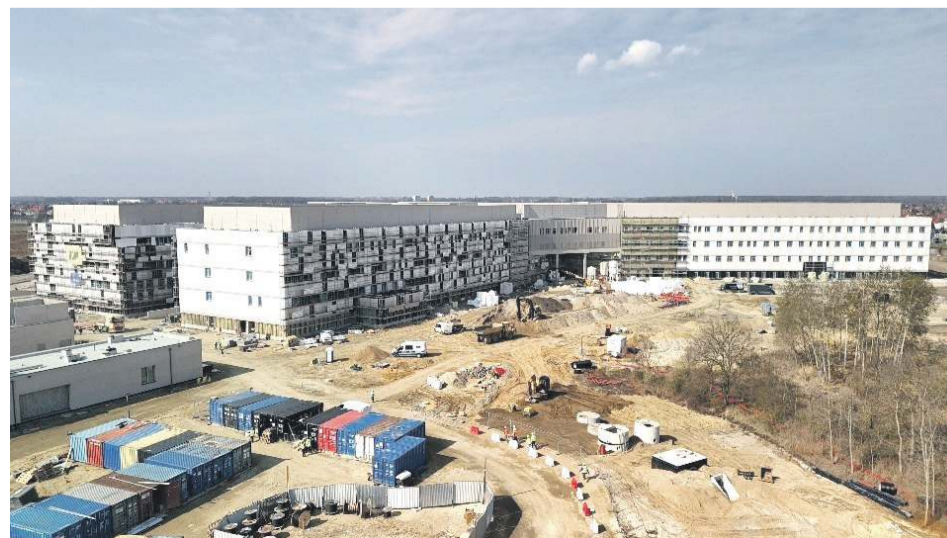
Budowa Nowego Szpitala Onkologicznego idzie pełną parą
