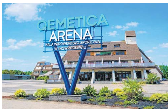
Wykonawca przygotować ma projekt i wykonać pylon
