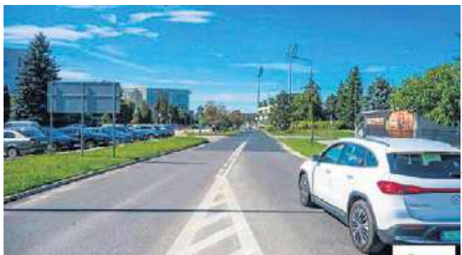
W wtorek rozpoczął się remont ulicy 1 Maja w Belchatowie
