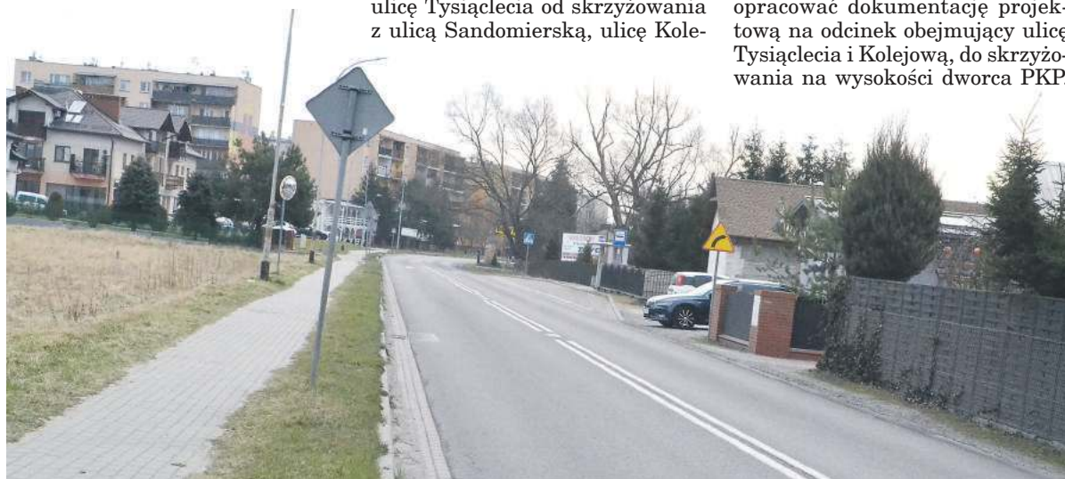
Prace przy przebudowie prowadzone będą w dwóch etapach. Pierwszy, który będzie realizowany w tym roku, obejmie projektowanie, zaś drugi faktyczną przebudowę drogi. Prace ziemne mają ruszyć w 2023 r.
