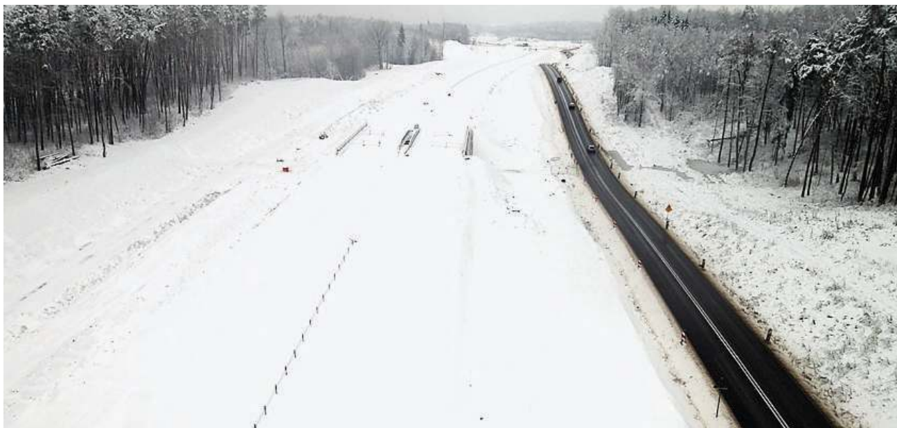
W połowie tego roku ma zakończyć się budowa S16 Borki Wielkie – Mrągowo
