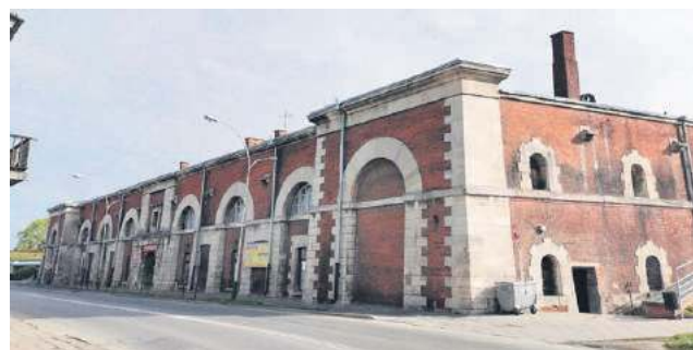
Dach na budynku Ekonomika będzie podniesiony. Na poddaszu powstanie szereg pomieszczeń, z których korzystać mają uczniowie i mieszkańcy Zamościa. Fot. UM Zamość
