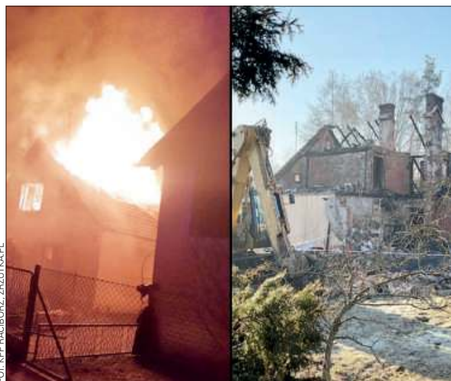
Ogień całkowicie strawił budynek
