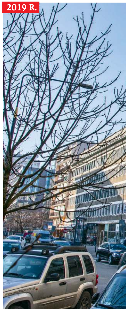
Żurawia 28 – wielkomiejską kamienicę zastąpiła ściana
