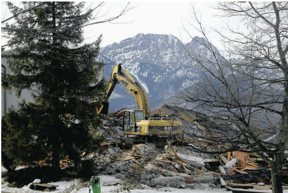
• Nielegalna rozbiórka domu wypoczynkowego Panorama FOT. MAREK PODMOKLEY / AGENCJA WYBORCZA.PL
