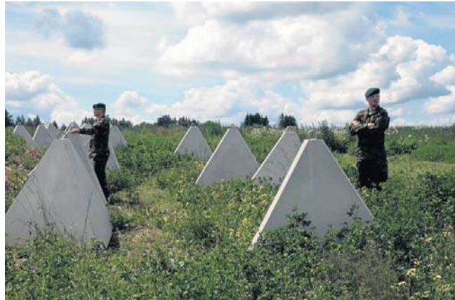
Bałtycka Linia Obrony na granicy Estonii i Rosji. Na zdjęciu widać tzw. smocze zęby
