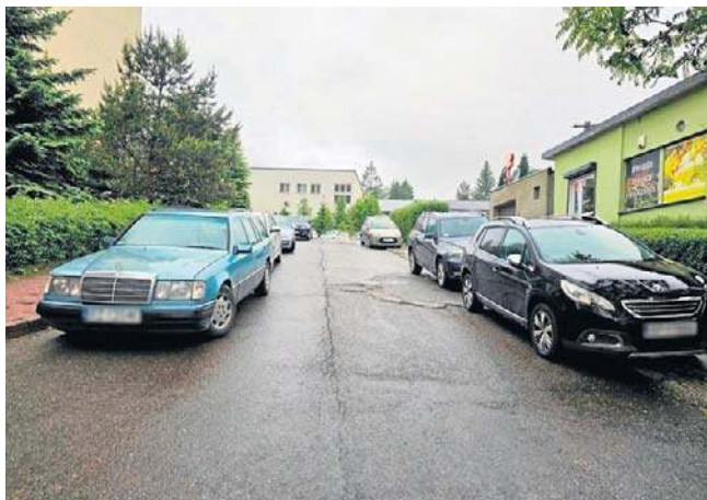
Mieszkańcy mają trudności z parkowaniem, a służby ratunkowe mogą mieć utrudniony dojazd
