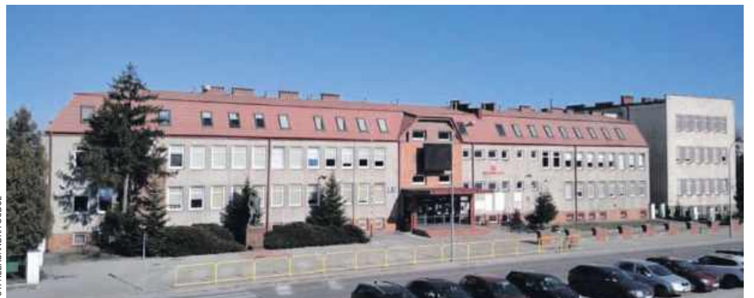
Szkoła przed termomodernizacją
