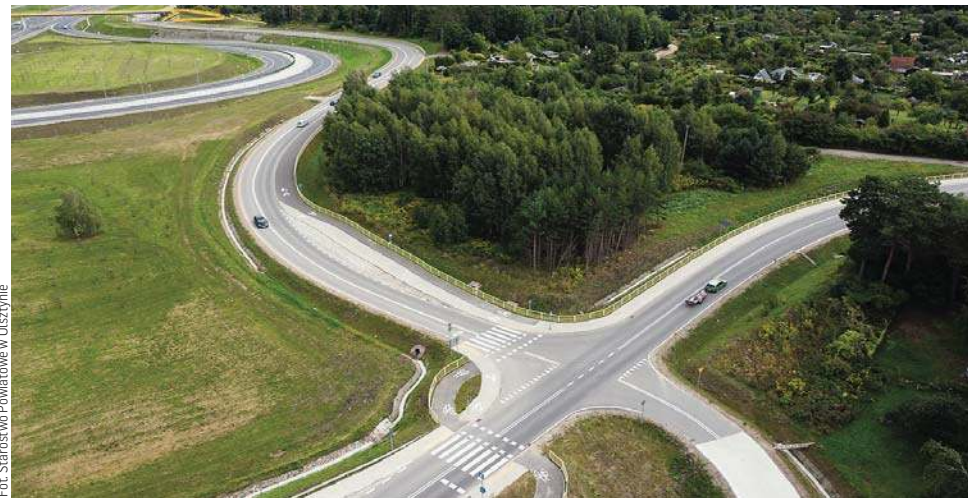
Fragmenty niedawno oddanej do użytku małej obwodnicy Klebarka
