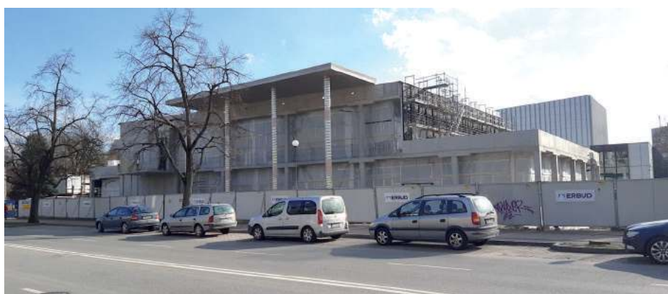
Z placu budowy przy ul. Wojska Polskiego zniknęły już dźwigi budowlane. Prace przeniosły się do wnętrza budynku
