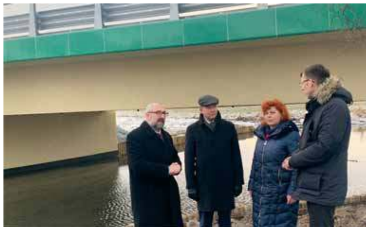
Samorządowcy na tle wyremontowanego mostu
