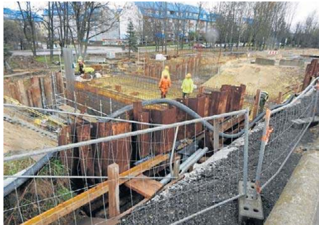
Przebudowa DK 94 w Olkuszu. Prace trwają na dużym odcinku, mają skończyć się we wrześniu
