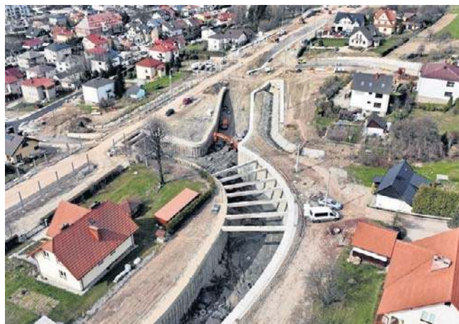
Limanowa, nowe skrzyżowanie w rejonie ul. Źródlanej. Droga będzie bezkolizyjnie przechodzić pod torami
