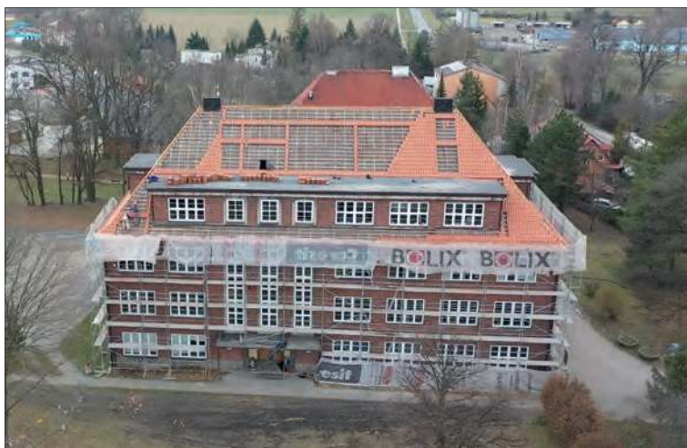
Remont dachu budynku II LO
