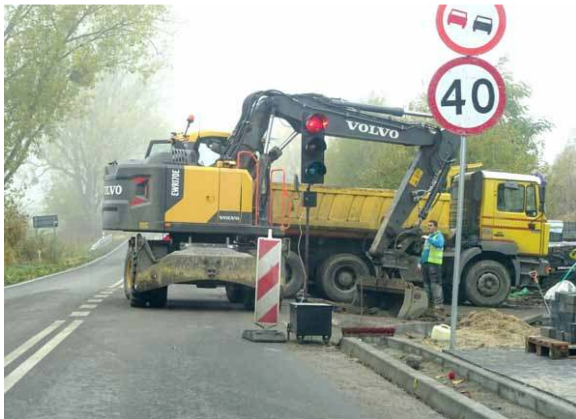
Budowa ścieżki Zalando - Gryfino zbliża się do miasta.
