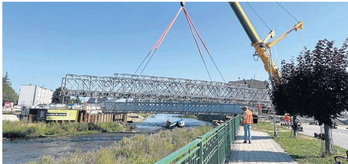
Rozbiórka mostu tymczasowego rozpoczęła się kilka dni po otwarciu nowego mostu w ciągu DK 40.
