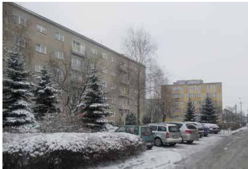
Problem występuje głównie na osiedlu Orlika, ale też w centrum i na nowych osiedlach
