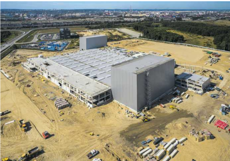
• Fabryka Northvolt w Gdańsku podczas budowy, wrzesień 2022 r.
