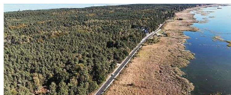
Zakończył się remont drogi wojewódzkiej nr 501 na odcinku łączącym Stegnę z Krynica Morską. Przebudowa 17 kilometrów trasy trwała dwa lata i kosztowała 103 mln zł
