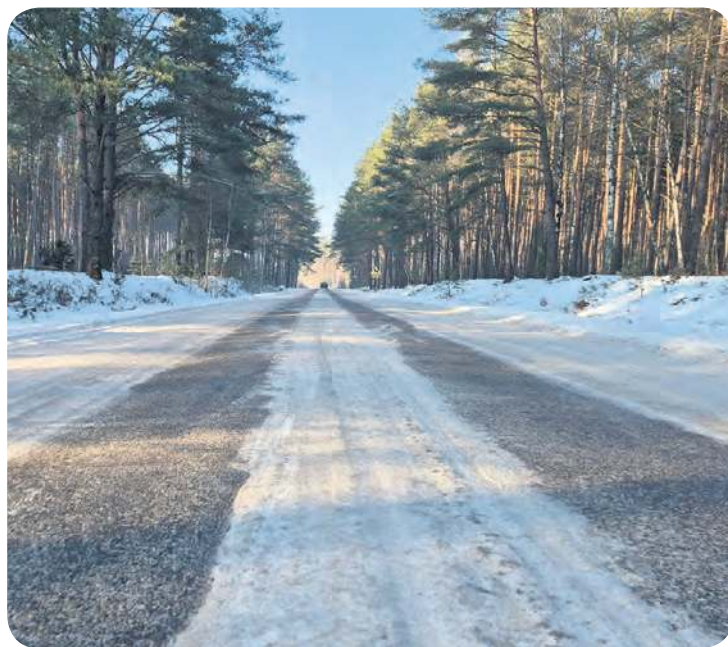
22 stycznia droga powiatowa pokryta była warstwą lodu.
