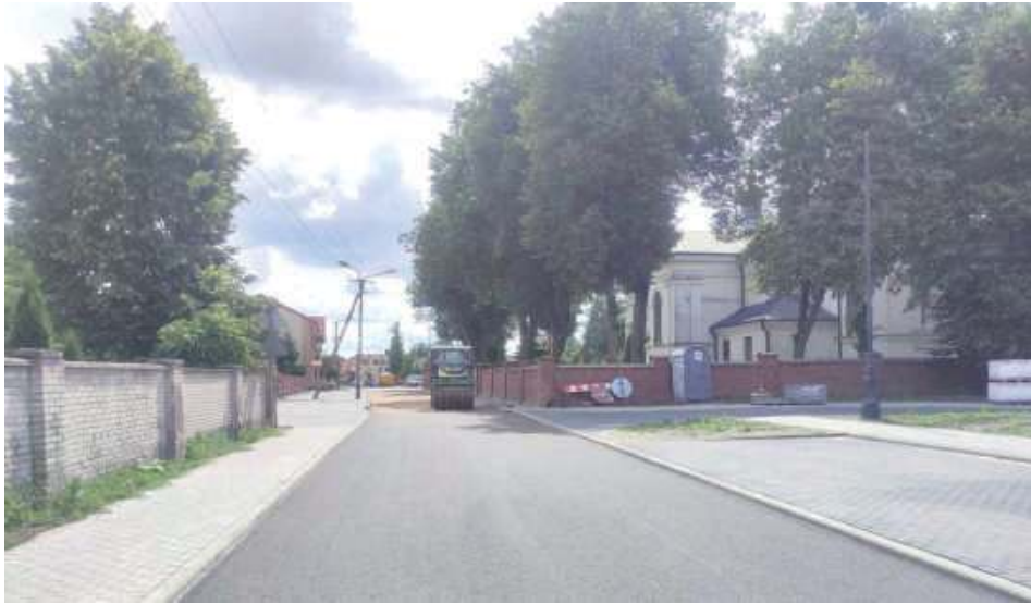
Finalizują się modernizacje dróg i budowa parkingu przy Urzędzie Gminy. Parking jest już budowany, wykonano kanał technologiczny i chodniki
