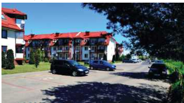
W tej chwili TBS dysponuje pięcioma blokami przy ul. Lipskiej i dwoma przy Chłodnej. Fot. TBS
