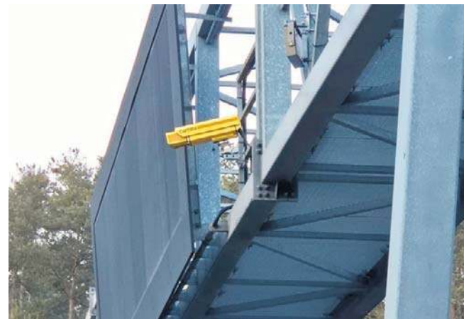
Odcinkowy pomiar prędkości powstaje na S6 pomiędzy węzłami Kołobrzeg Wschód i Kołobrzeg Zachód
