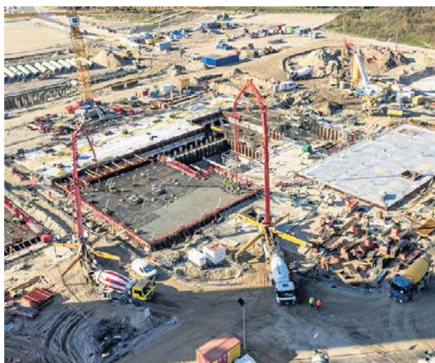
Prace fundamentowe na budowie elektrowni w Gdańsku
