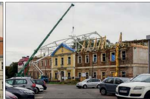
Tak obecnie wygląda pałac. Budowalcy stawiają metalową konstrukcję, by dokończyć nową kondygnację.
