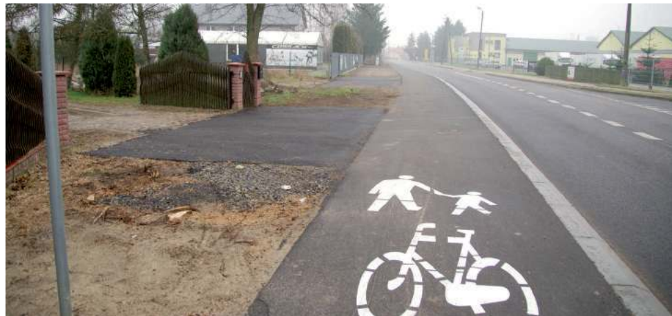
Zjazd na posesję z torami przy ul. Kolejowej w Parczewie
