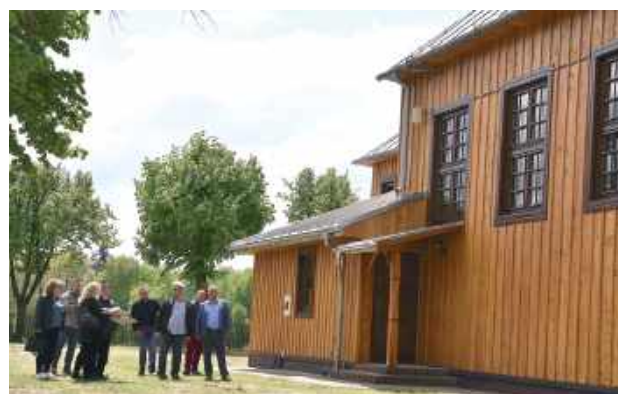
W odbiorze uczestniczył wójt Dariusz Świerczyński, który nie krył zadowolenia z efektu końcowego oraz pracownicy Referatu Inwestycji Urzędu Gminy Biłgoraj, Inspektor nadzoru Michał Karwatowski, Kierownicy budowy Kazimierz Przekłasa i Cezary Kołtunowicz, wykonawcy Tomasz Smosna „GRANIMEX” Firma Usługowo-Handlowa i Zenon Bielak DREWBUD DOMY z DREWNA Sp. z o.o.
