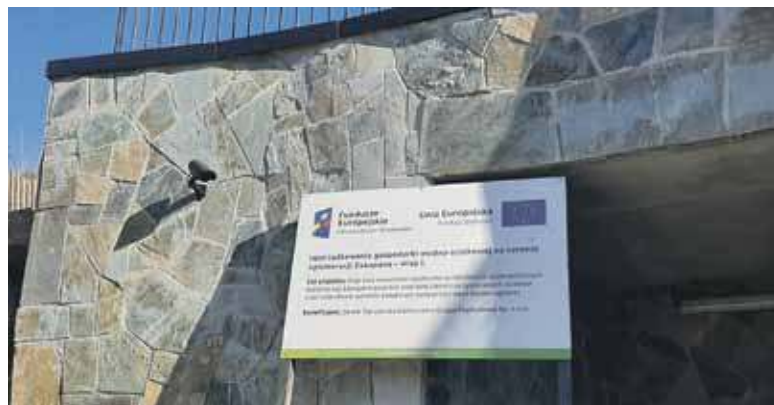
Tablica o inwestycji z unijnych pieniędzy nie dotyczy podniebnej drogi, a stacji hydroforowej i sieci wodno-kanalizacyjnej na Toporach.
