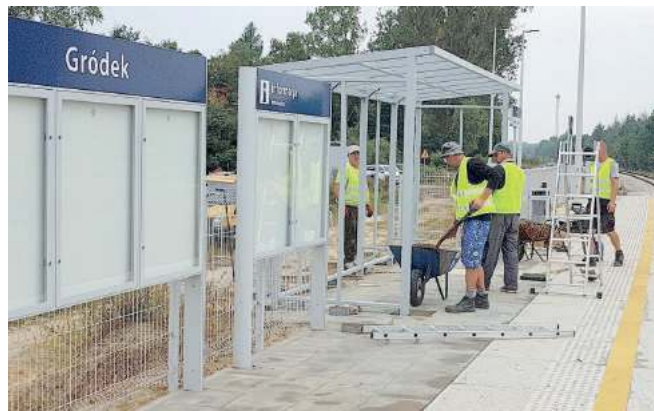
Budowany jest peron na przystanku Parczew Kolejowa oraz peron w Gródku (gm. Siemień). Przygotowano oświetlenia, montowane są ławki, wiaty, ogrodzenie oraz gabloty na rozkład jazdy pociągów
