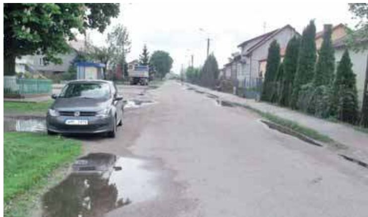
Droga przez Kowalewo przed modernizacją
