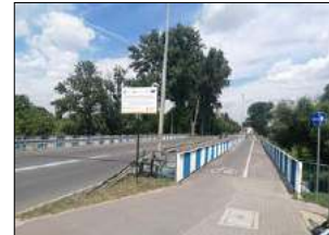
Na remont mostu na ul. Łomaskiej miasto przetarg unieważniło
