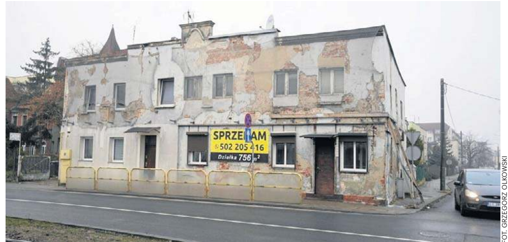
Tak prezentuje się obecnie budynek pod adresem Lubicka 29/Gołębia 1 - widok od strony ulicy Lubickiej
