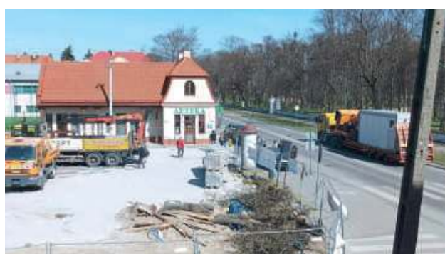
28 marca br. nastąpiło przekazanie zakresu robót rewitalizacyjnych na Rynku spółce SORTED. Dotychczasowa firma zrezygnowała z dalszych prac
