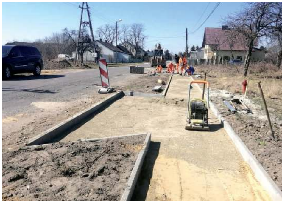
GINA WOHYŃ Chodnik w Suchowli układają pracownicy radzyńskiego PUK. To 725 m.b. chodnika z szarej kostki brukowej o szer. 1,5 m wraz z obrzeżami oraz zjazdów na posesje. Prace wykonuje PUK Radzyń Podlaski za cenę 115 tys.zł.
