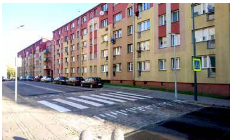
Zakończyła się budowa wyniesionego przejścia dla pieszych na ul. Kazimierza Wielkiego
