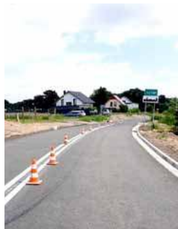
Powiat ubiega się o dofinansowanie inwestycji z Rządowego Funduszu Wsparcia Inwestycji Lokalnych
