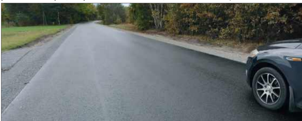
Nowo odremontowana nawierzchnia w Płazówce.
