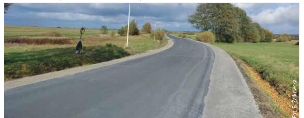
Nowo przebudowana droga powiatowa Wola Ranizowska - Wilcza Wola.
