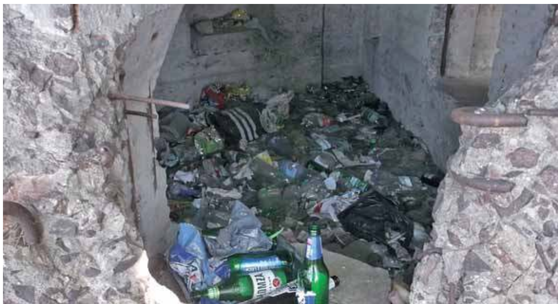
Tak wygląda wnętrze schronu nad zalewem w Rudzie
