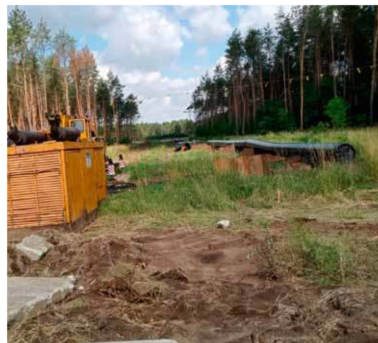
Rurociąg gazowy dotarł już na przedpole elektrowni.
